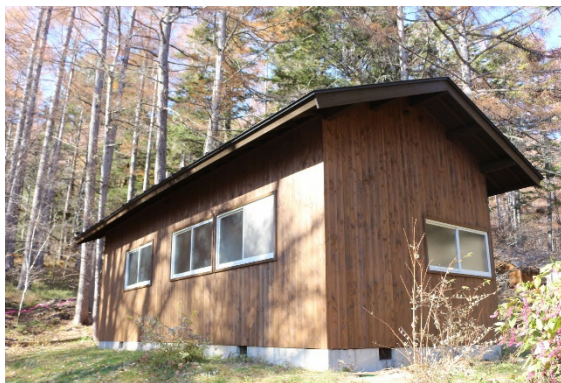
修繕した避難小屋
