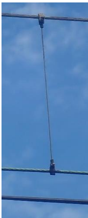
正常のドロツパ (当該箇所は長さ1,600mm)
