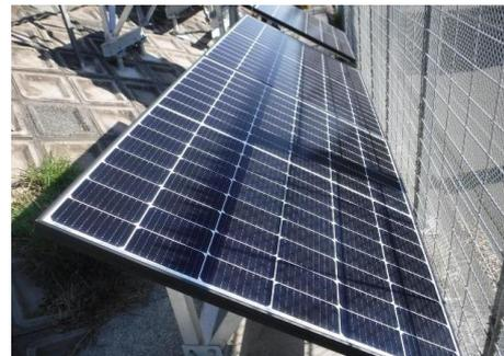
新幹線の「のり面」に設置する太陽光パネル
