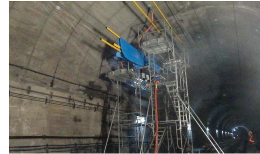
大規模改修工事
