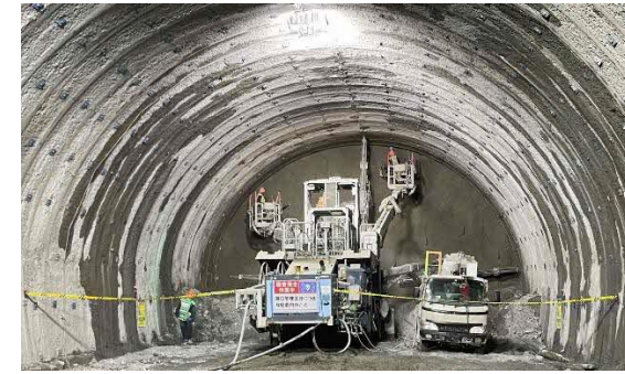
伊那山地トンネル(青木川工区) 本線トンネルの掘削(中央構造線部)
