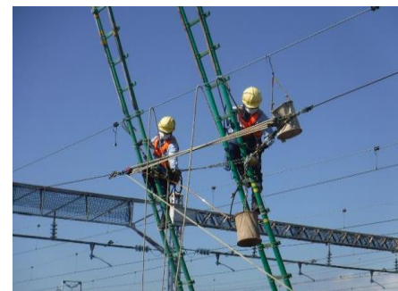
梯子作業で架線を接続
