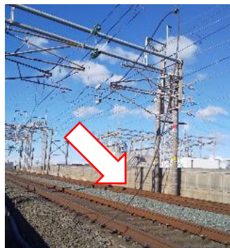
架線が断線し垂下
