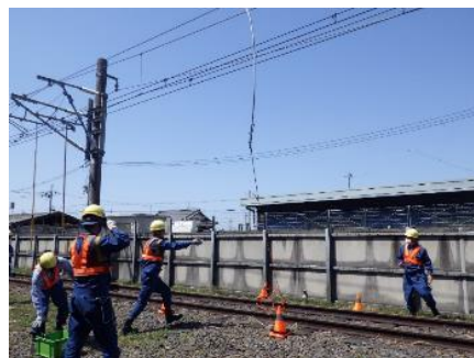
故障した架線を仮復旧
