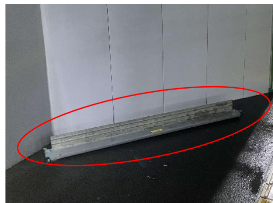
落下していた仮設足場材
