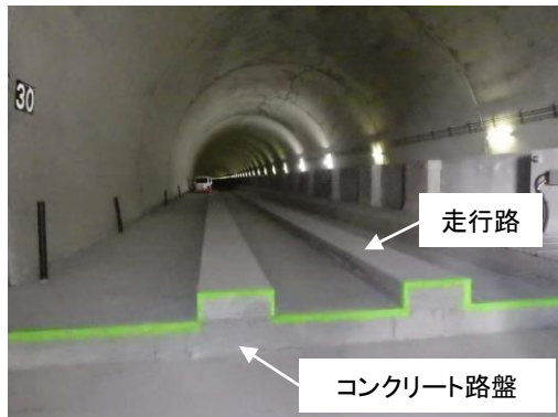
山梨リニア実験線トンネル区間における トンネルコンクリート路盤及び走行路 (実証試験の様子)
