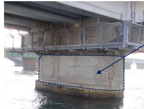
東海道新幹線 浜名橋りょうの橋脚補修のひび割れ防止 (塩害防止対策)
