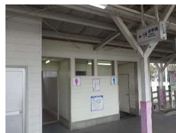
旅客トイレ改修前
