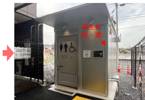
葛生駅旅客トイレ（改修後）
