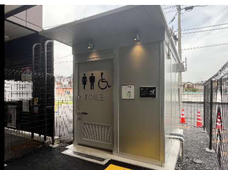
葛生駅旅客トイレ（改修後）
