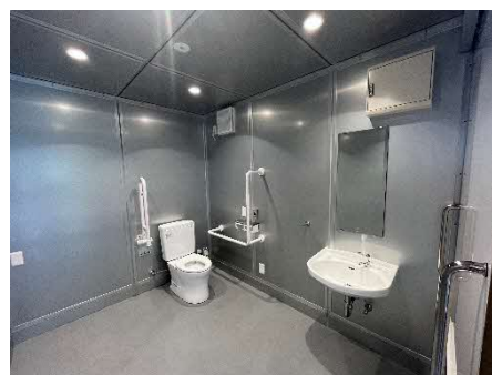
改修後の内観
