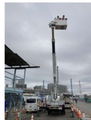
高所作業車 (東京電力ＰＧ)
