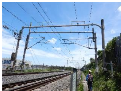
徒歩巡回での外観検査
