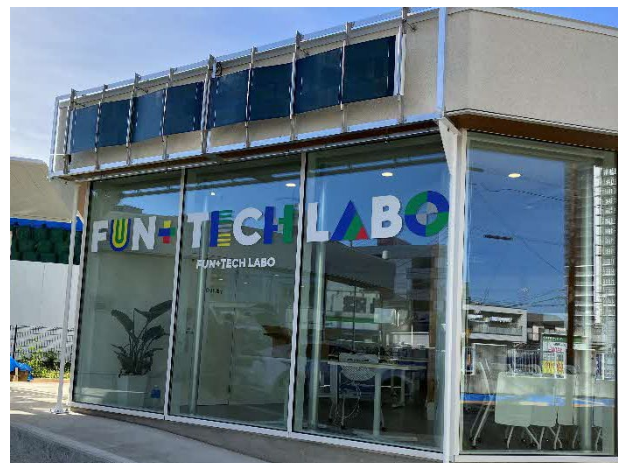
「シート工法」を用いて壁面に設置されたモジュールの様子
