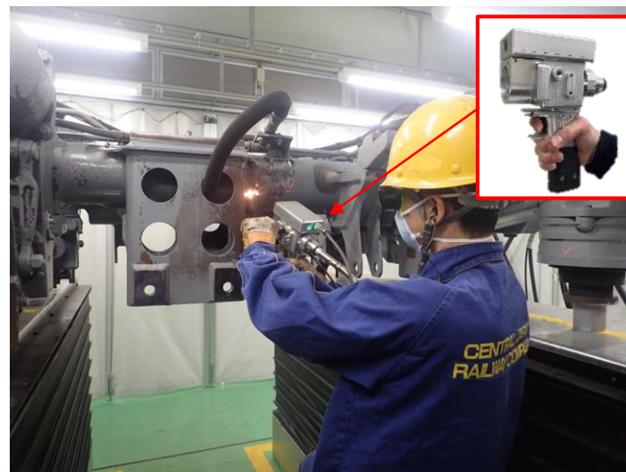
〔新規〕 レーザによる塗膜除去
