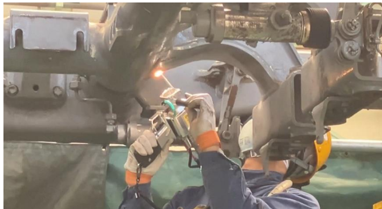
図：レーザブラスト技術を用いた塗膜除去作業
