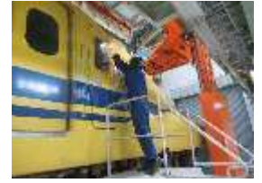
乗務員室扉の整備の様子 ※パネルなどをご紹介します
