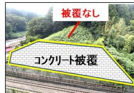
一部コンクリート被覆
