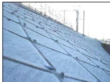
全面コンクリート被覆 (枠内:コンクリート)
