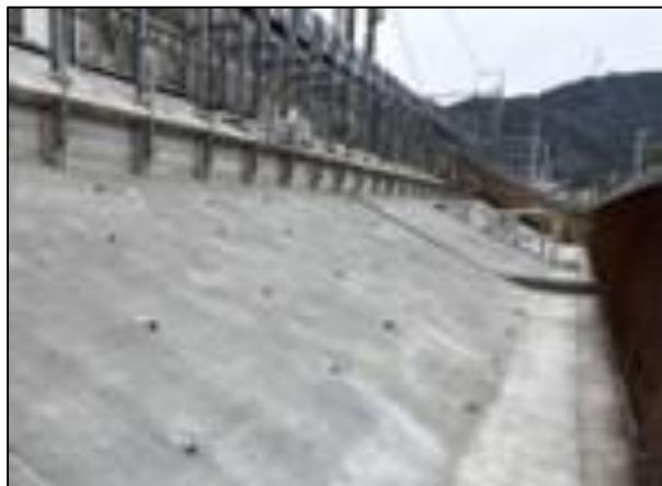
全面コンクリート被覆
