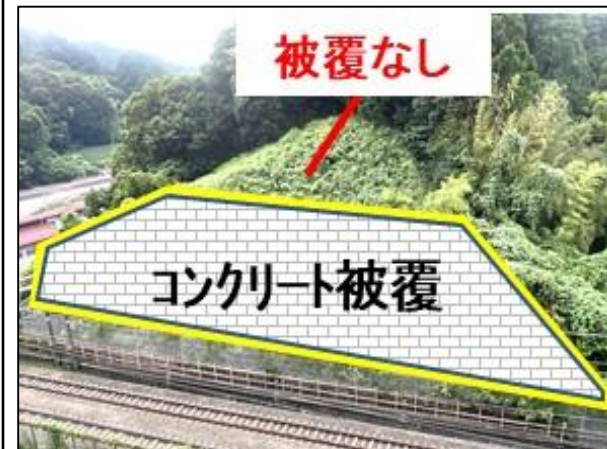
一部コンクリート被覆
