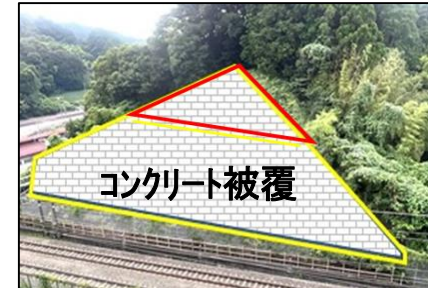
全面コンクリート被覆
