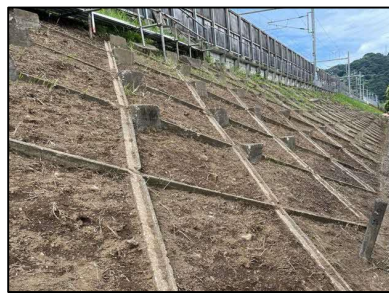
コンクリート製の枠で強化 (枠内:土)
