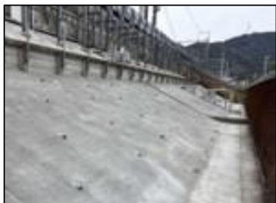
全面コンクリート被覆
