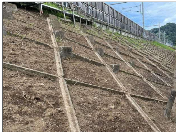
コンクリート製の枠で強化(枠内:土)
