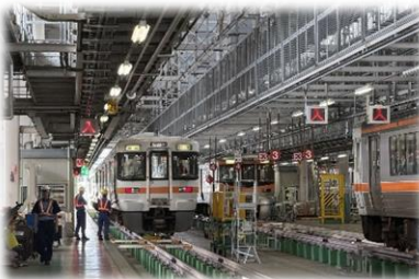
《静岡車両区検修庫見学》
