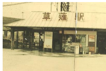
橋上駅舎完成前の草薙駅
