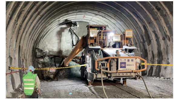
南アルプストンネル（山梨工区） 本線トンネルの掘削
