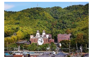
サントリー「山崎蒸溜所」
